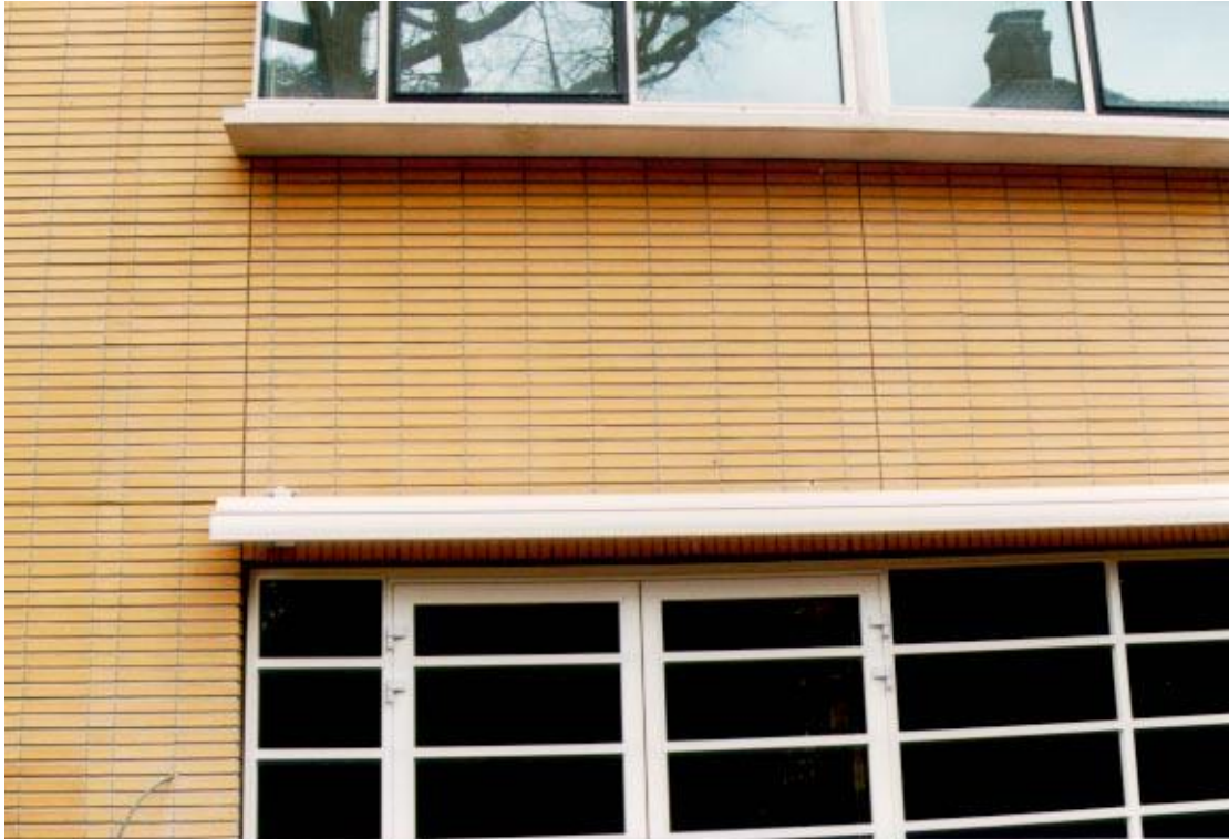
foto 1. Tegelverband in de gevel van het AKN gebouw te Hilversum , Architect Jan Hoogstad 2000
